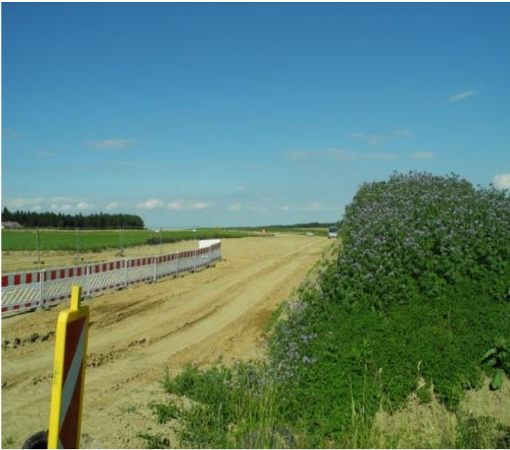
Hier wird eine Gasleitung gebaut. Phazelia zur Begrünung - Bienenweide
